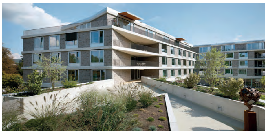
Auf dem Dach des westlich gelegenen eingeschossigen Solitärbaus wurde eine direkt zugängliche spalierartig bepflanzte Aussenanlage für die Demenzstation erstellt.
