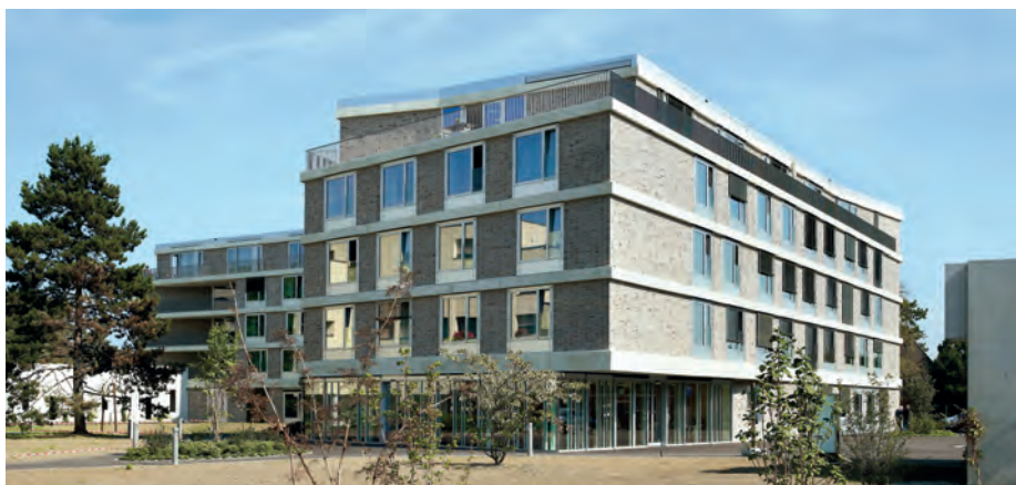
Die Stiftung Bethesda Basel hat mit dem Alterszentrum Gellert Hof in Basel dringend notwendige Pflegeplätze realisiert. (Bilder: zVg)
