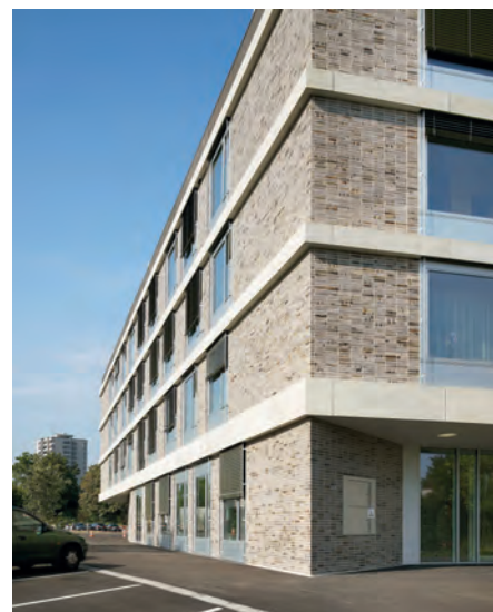
Als Reminiszenz an die Sichtbacksteingebäude der Gründerzeit im Gellertquartier sind die geschlossenen Fassadenbereiche mit einem warmgrauen Klinker verkleidet.
